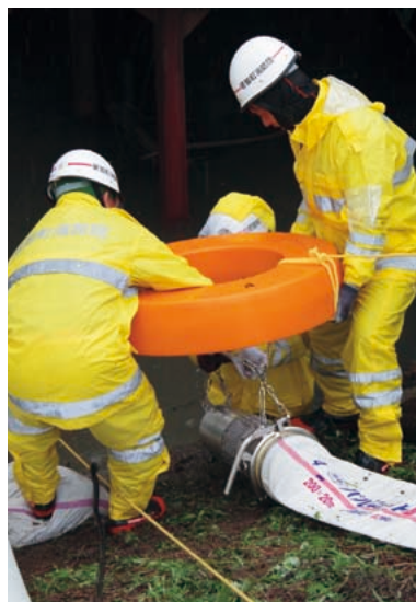
豪雨時排水作業 (令和2年7月)
