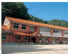
山間に建つ高市小学校の校舎
