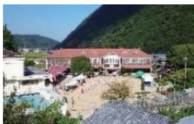
翠小学校の木造校舎
