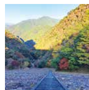
ダムから国道 379号線を臨む
