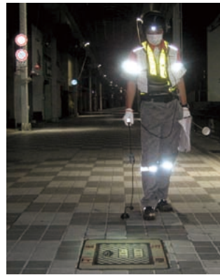
作業中の作業員
