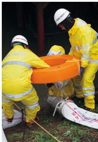
豪雨時排水作業 (令和2年7月)
