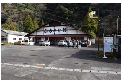
仮置場候補地全景 2
