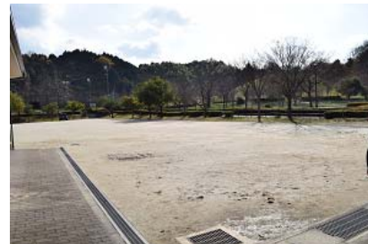
暗渠が設置されている
