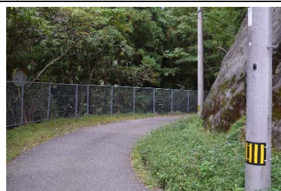
処分場への進入路の状況
