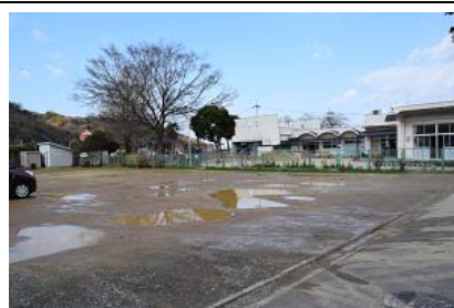
水はけが悪い麻生幼稚園側
