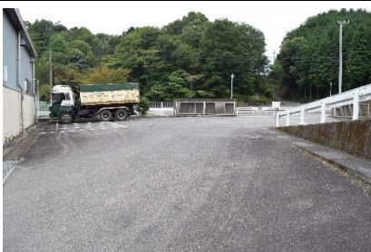
入口の駐車スペース
