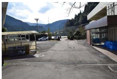
旧広田支所出入口
