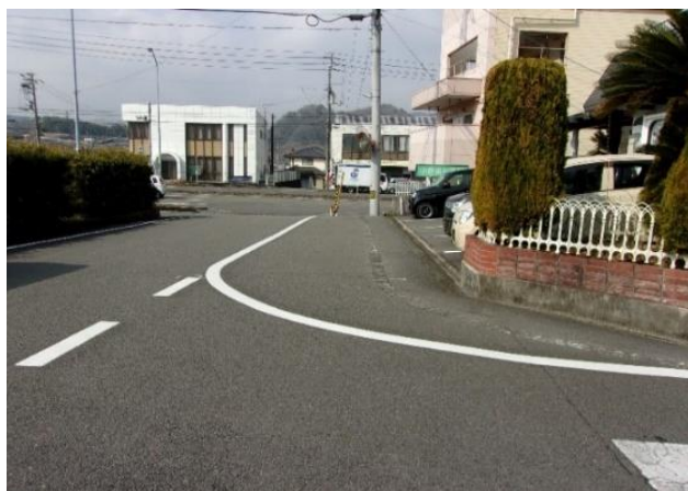
外側線引き直し、路肩幅拡張
