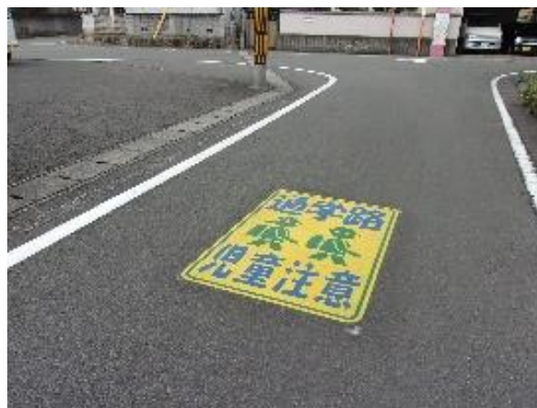
路面標示シール設置
