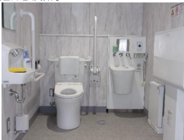
多目的トイレ新設
