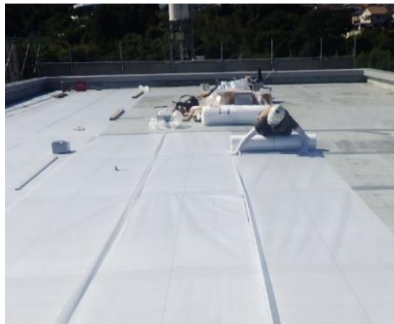
防水改修工事
