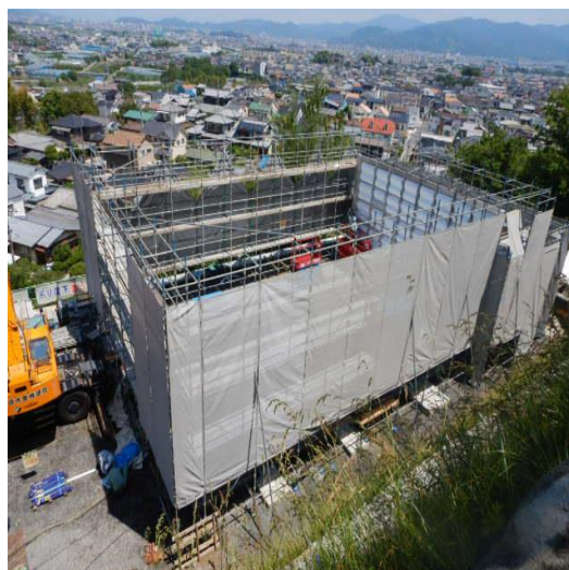
第6配水池築造工事（南ヶ丘区の南側）
