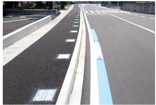
県道大平砥部線設置用陶板設置状況
