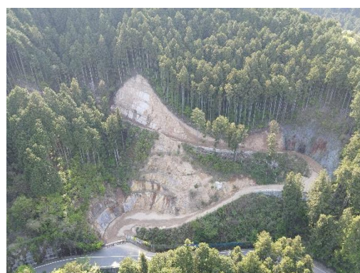
砥部町整備分 延長 L=3.4 km 整備済み L=0.3 km
