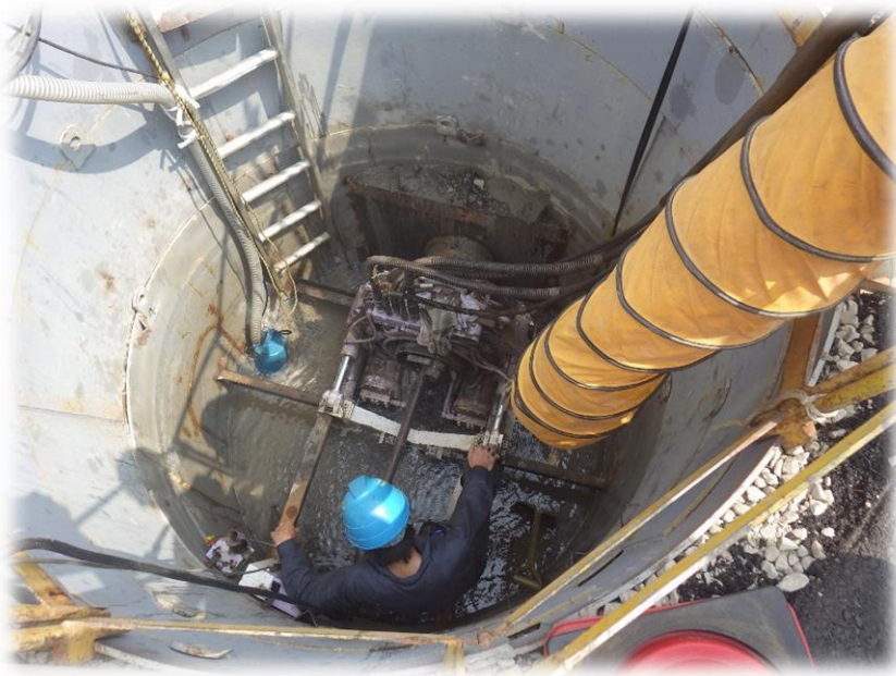
下水道工事のようす
