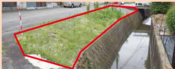
町道御坂川支線(高尾田)
