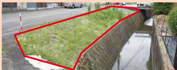
町道御坂川支線(高尾田)
