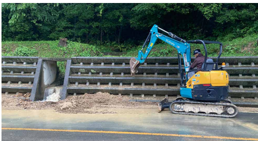
災害時に業者の重機が役立っています
