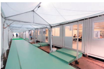
仮設ハウス・仮設通路
