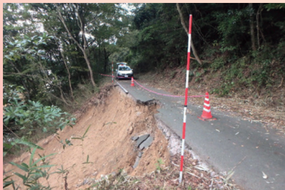
町道大谷谷上線 道路災害復旧工事
