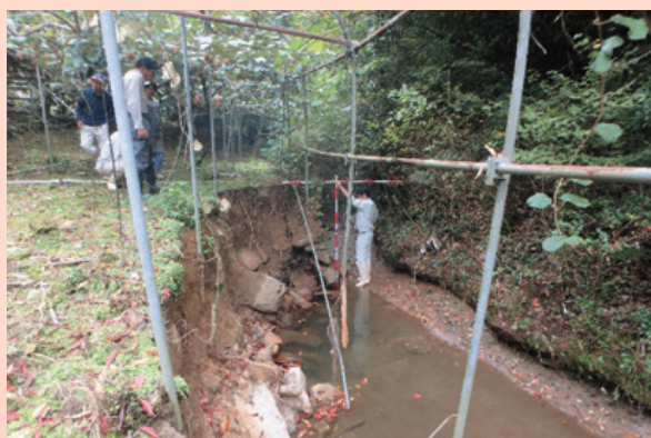
古岩谷川 河川災害復旧工事
