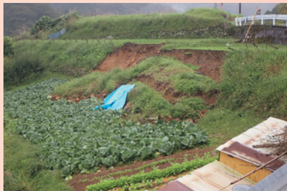
大内野畦畔 農地災害復旧工事
