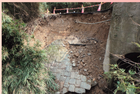
町道重光田の浦線 道路災害復旧工事
