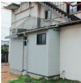
解体される旧原町連絡所
