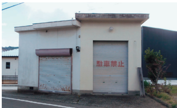
解体される消防団の器具倉庫
