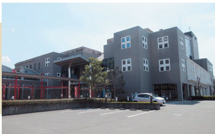
工事が始まる文化会館
