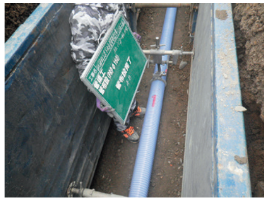
下水道供用区域を拡大中
