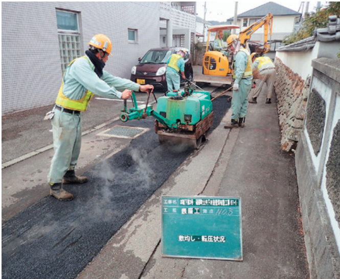
下水道工事完了後の舗装作業
