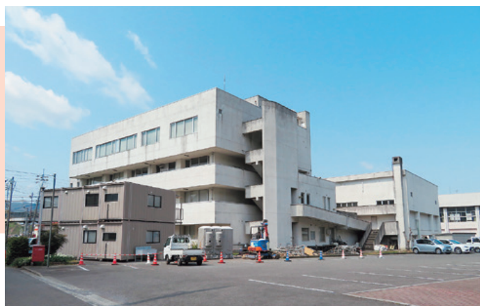
▲工事が始まる中央公民館東側
