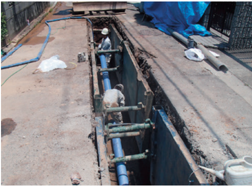
下水道管理設工事
