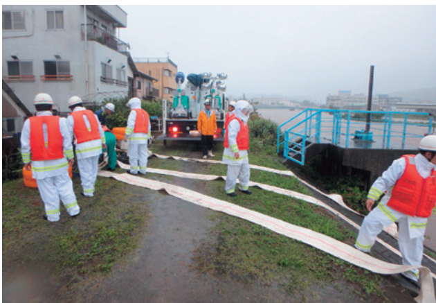
排水作業風景
