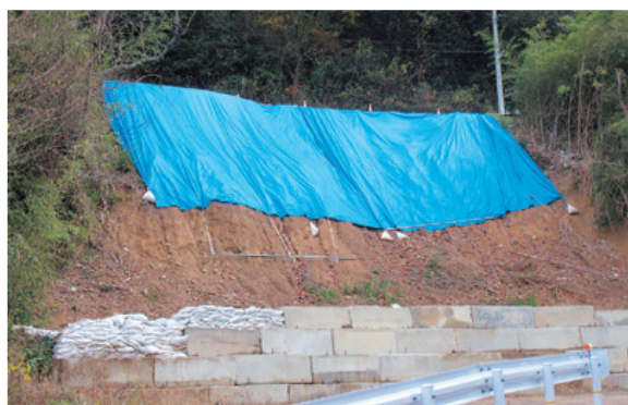
町道宮内塩ヶ森線 他24件工事費 2億56万円
