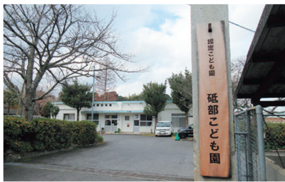
砥部こども園倉庫建築工事費 859万円
