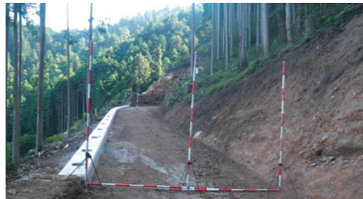
工事が進む障子山林道
