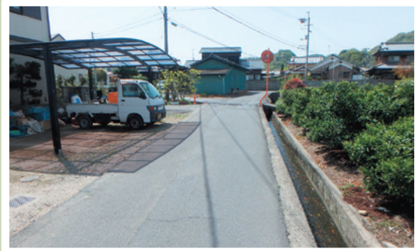
町道補修工事費(町道重光赤坂線ほか4件) 4,650万円
