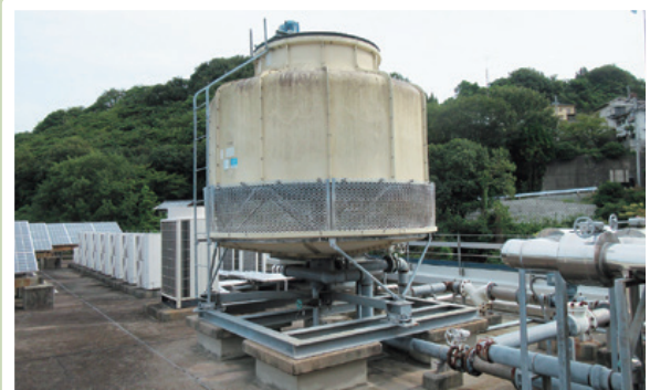
庁舎空調機補修工事費 521万円
