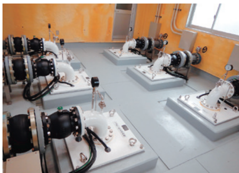
第4水源地ポンプ室
