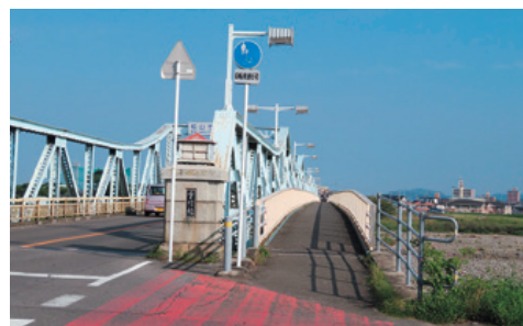
歩道が狭い重信橋
