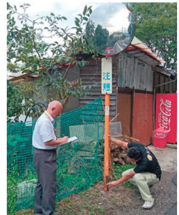
職員によるカーブミラーの点検
