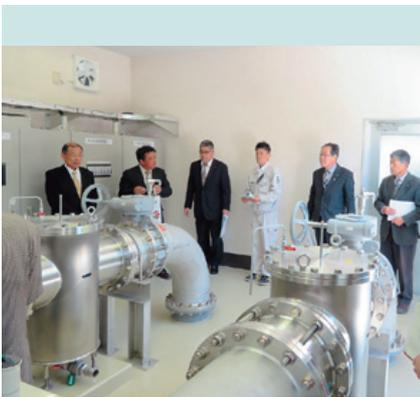
第4水源地に設置された紫外線照射装置
