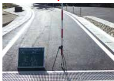
久保田深田線改良工事
