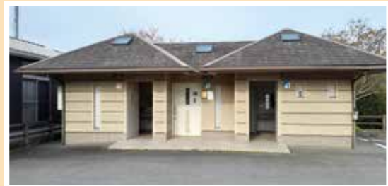
(トイレ改修・改築工事2件)
