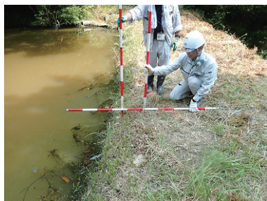
ため池を点検中
