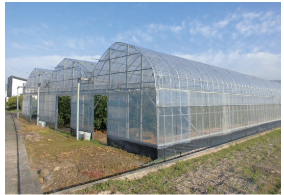
ビニールハウスも補助対象
