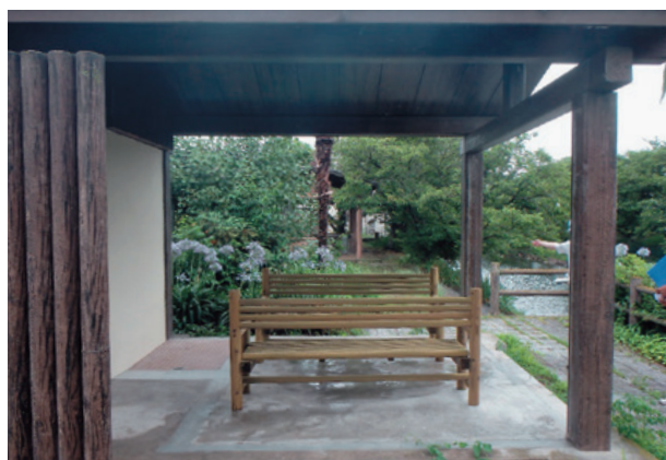
赤坂泉公園更衣室改修工事
