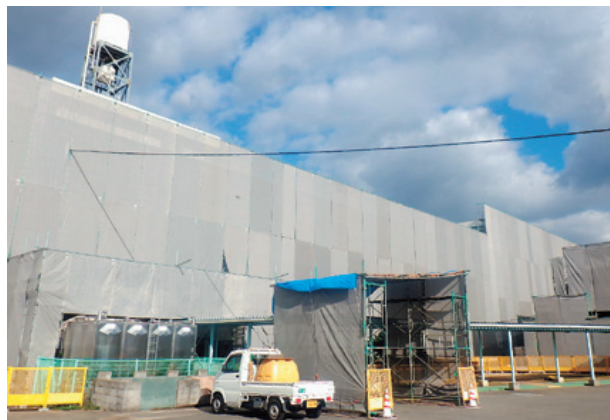
宮内小学校大規模改修
