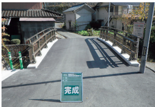
橋修繕工事（5 橋）
