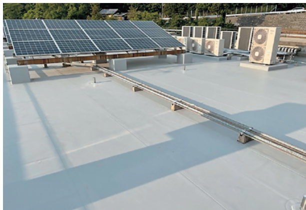
庁舎屋上防水工事
