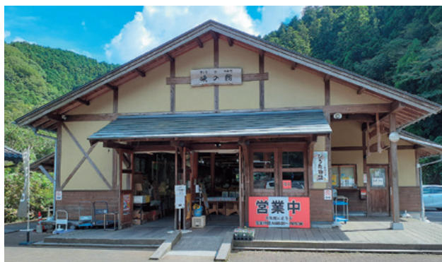
町内唯一の道の駅（峡の館）
