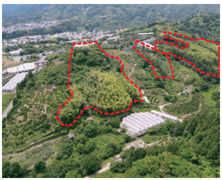
支障木伐採予定地（北川毛角谷地区）
