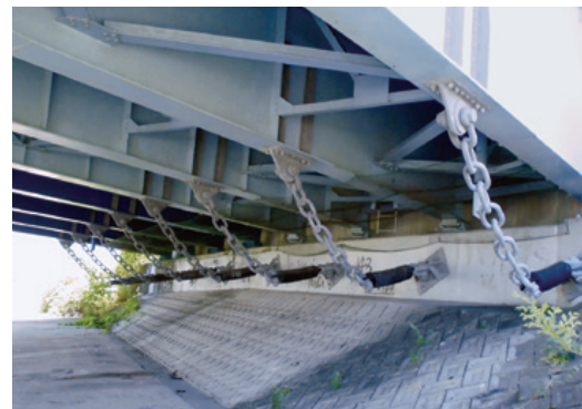
国により耐震化された橋（重信大橋）
