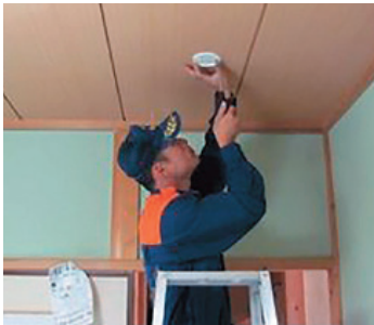
火災警報器の取り付け
