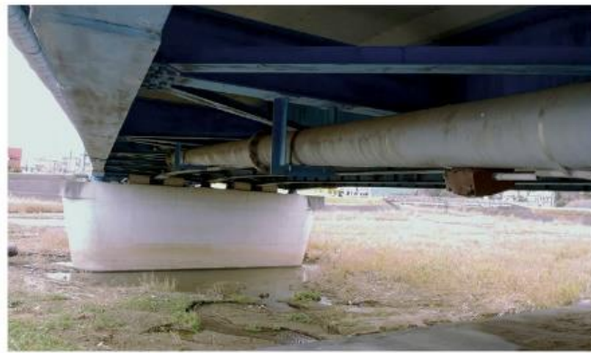
麻生橋の橋梁添架
