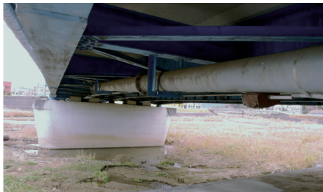
麻生橋の橋梁添架
