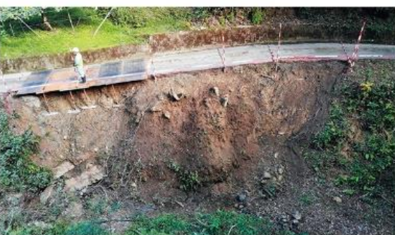
農道持谷線（川井）
