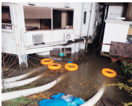
高尾田の浸水状況（平成29年災害時）
