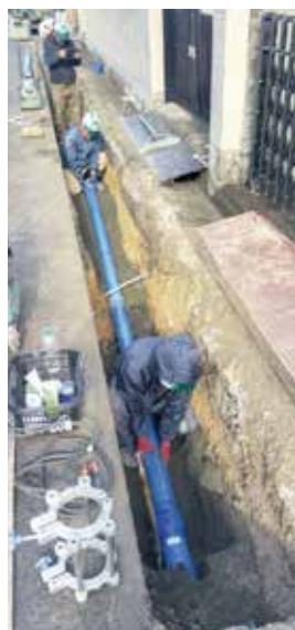
水道管路の更新
