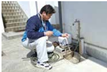
検査作業の様子
