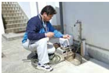
検査作業の様子
