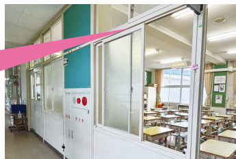
教室と廊下の間の窓
