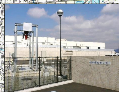
公共下水道浄化センター
