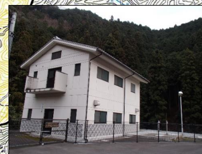
総津地区農業集落排水処理施
