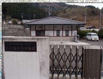
広田地区農業集落排水処理施
