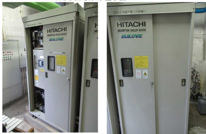
灯油焚き吸収冷温水機20RT
