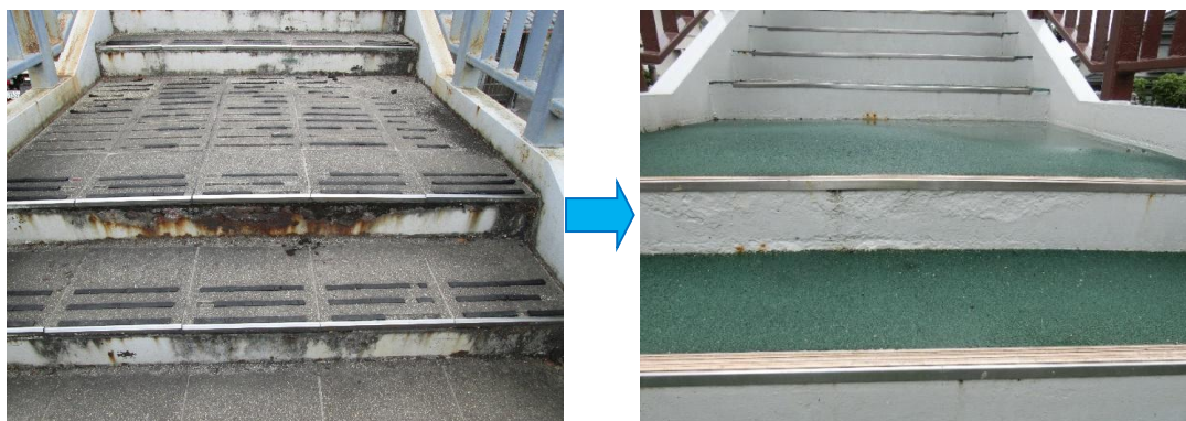
図4 塗装塗替え（階段部）
