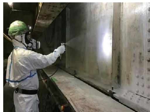
図 7 新工法活用事例（EPP 工法）
