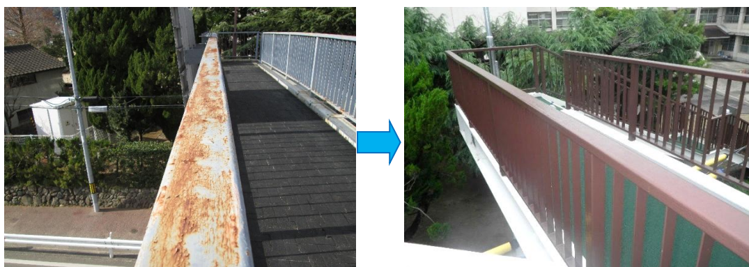
図5 塗装塗替え（高欄）
