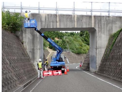
図4 点検状況写真（高所作業車）
