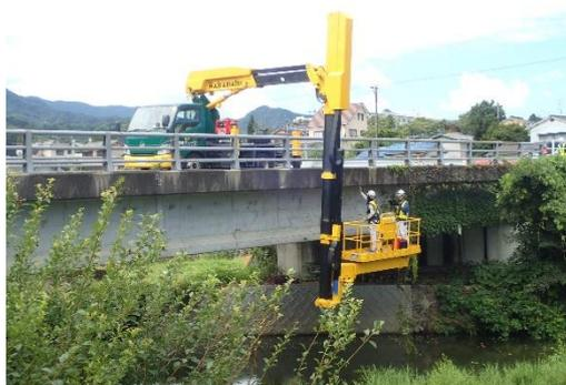
図3 点検状況写真（橋梁点検車）
