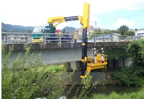
図3 点検状況写真 (橋梁点検車)
