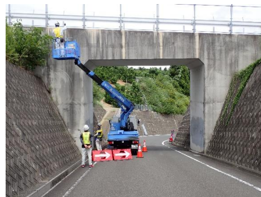
図4 点検状況写真 (高所作業車)
