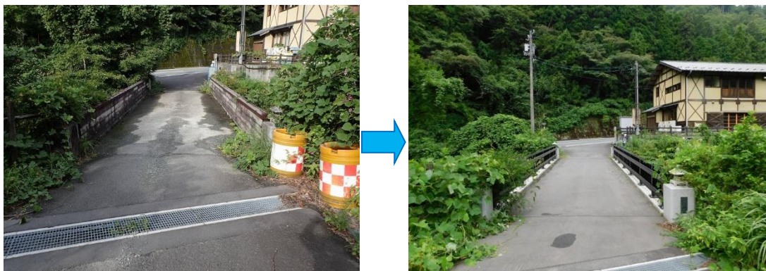
図9 防護柵取替及び舗装打ち換え（玉銅橋）
