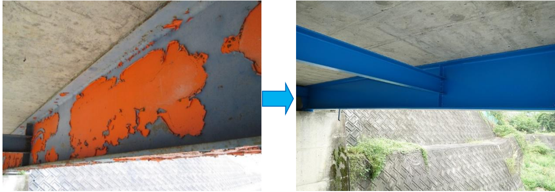
図7 塗装塗替え（六反地橋）
