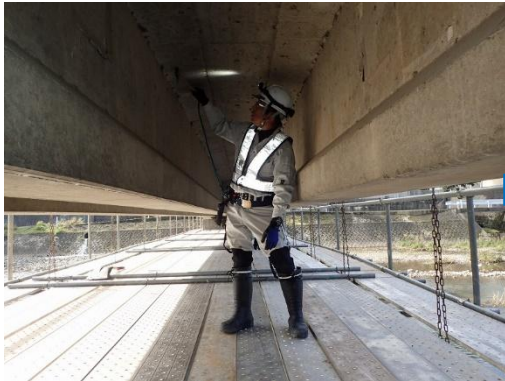
図 12 目崎橋 1 巡目点検（吊り足場）
