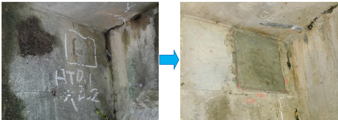
図8 断面修復（玉銅橋）
