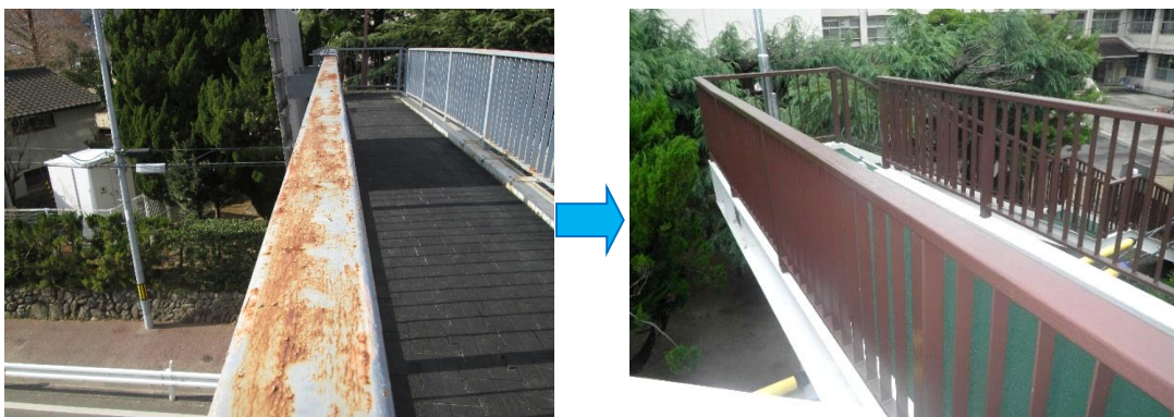
図5 塗装塗替え（高欄）
