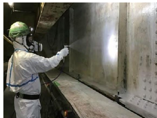
図 7 新工法活用事例（EPP 工法）
