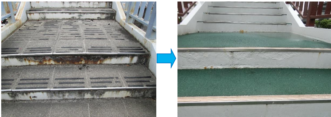
図4 塗装塗替え（階段部）
