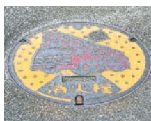
消火栓の一例
